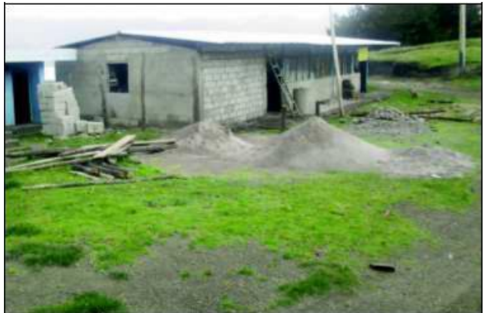
Der Rohbau im Juli 2017...
